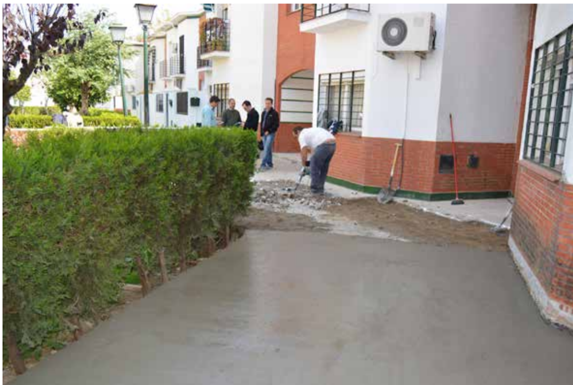
En la plaza de Santa Cruz se están realizando trabajos de impermeabilización del suelo.
