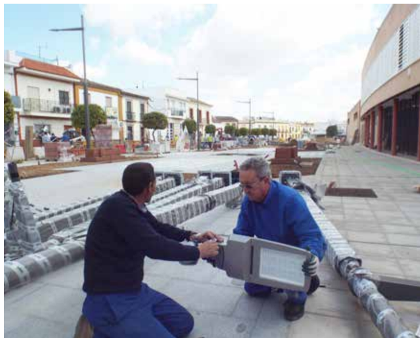
Operarios instalando las nuevas luminarias.
