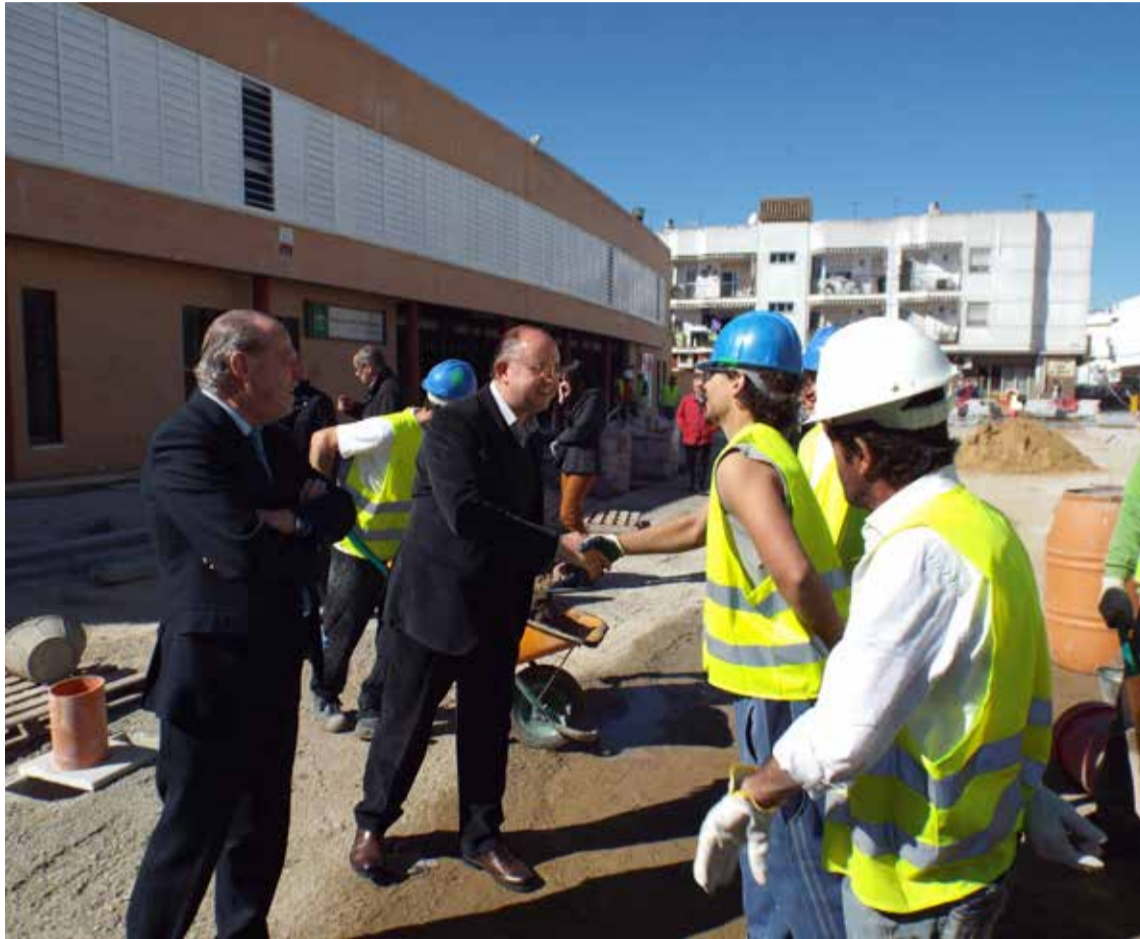
El Presidente de la Diputación visitó recientemente junto con el Alcalde los trabajos de remodelación del paseo.
