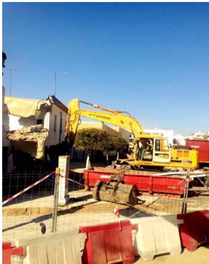
El derribo del antiguo cuartel hará posible la creación de una importante bolsa de aparcamientos públicos en el centro.
